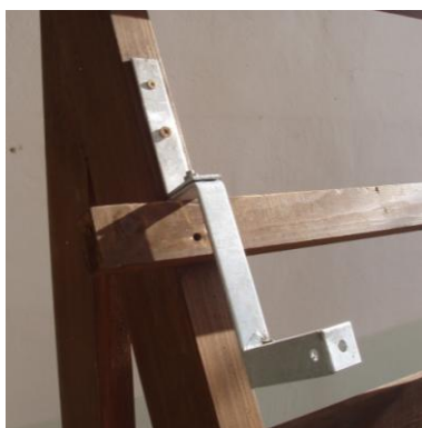
Montáž střešních háků do krokve
